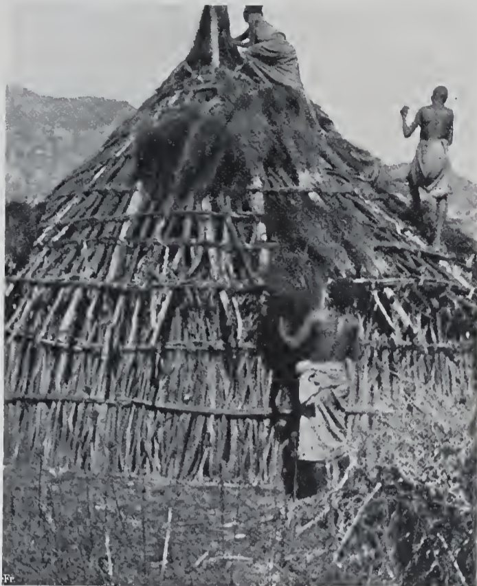
Abb. 27. Konstruktion eines Kegeldaches. Phot. E. Littmann.
